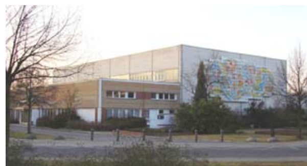
Finsterwalde: Gebäude auf dem Schul- und Sportcampus; Quelle: S. Haas, Hacon GmbH
