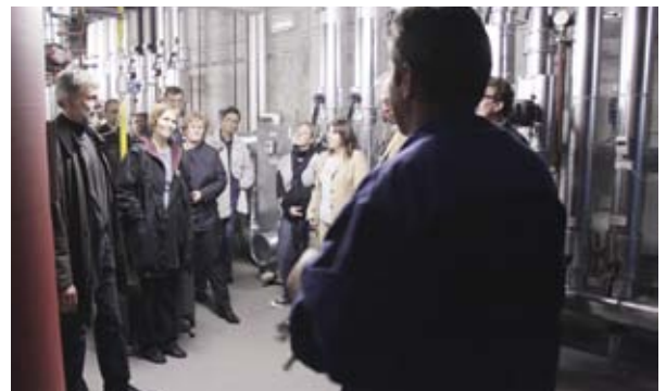
Das Pilotprojekt Warmwasserversorgung des IKMZ mit BHKW und Erdsonden wurde im Rahmen der 4. Erfahrungswerkstatt in Cottbus 2010 besucht.
